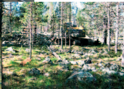
Kuva 10. Kaivinkone on nousemassa kvartsiittirakan yli kultapitoiseen hiertokontaktiin.
