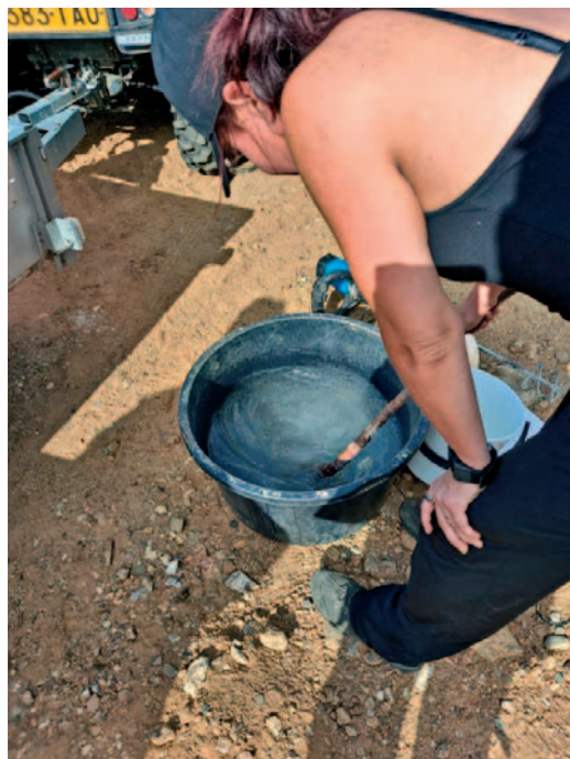
Flokkulantin liuotus, betonisekoittimella tai kepillä. Kuva: Veikko Jaskari
