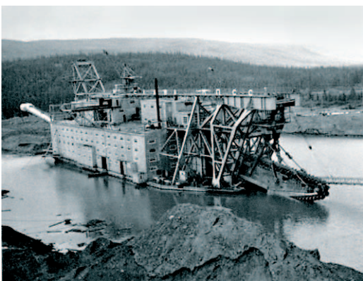
Maailman suurin ruoppaaja hankittiin vuonna 1969 Irkutskin alueelle. Voi kaivaa jopa 50 metrin syvyyteen. Venäjän kullankaivajien liiton tyypillinen jäsenyritys harjoittaa ruoppauskaivua.
