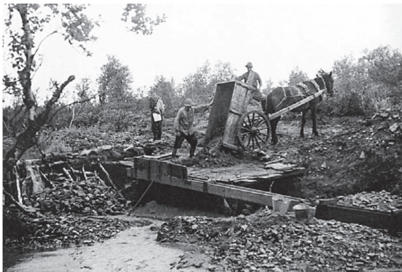
Ruittuäytsin hevostyömaa. Aaro Raumala ja Iisakki Mattus tyhjentävät kuorman kultaränniin Ruittuavdshilla. 24.8.1951. Herman Stigzelius, Geologian tutkimuskeskus
