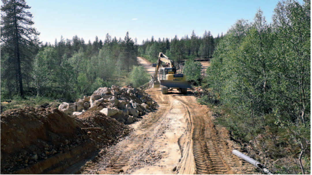
Sotajoen sillankorjaustyö hyvässä vauhdissa, murskeet oli ajettu paikalle jo etukäteen. Yöksi urakoitsija ajoi koneen poikittain sillan eteen tiensulukuksi.
