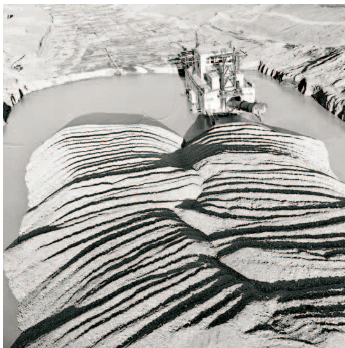
Ruoppaaja kaivaa kahta rinnakkaista linjaa.
