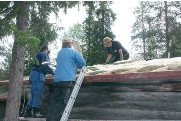
Kun liiton hallitus oli saanut vatuloitua muodollisuuspykälät alta pois, valmistui Kasöörin kämpän kattoremontti nopeasti.
