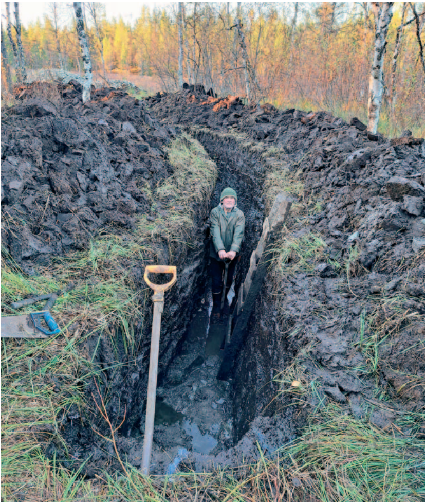
37 metriä uutta viemäriä. LKL:n valokuvakilpailun voittaja sarjassa “Kullankaivukulttuuri”. Kuva: Nanna Rytkönen
